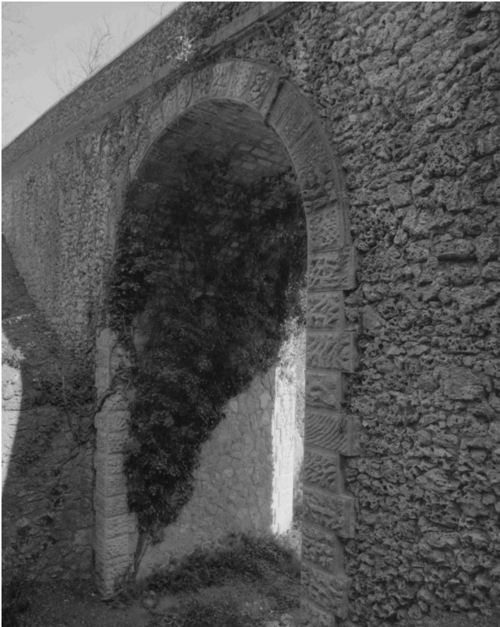
Ponceau sur le ruisseau de Flamenche. Vue de l'arche.
