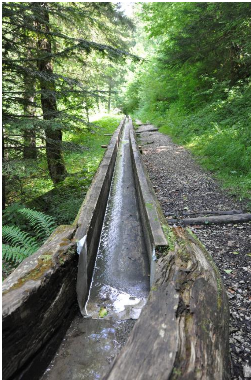
Vue du chenal d'amenée.
