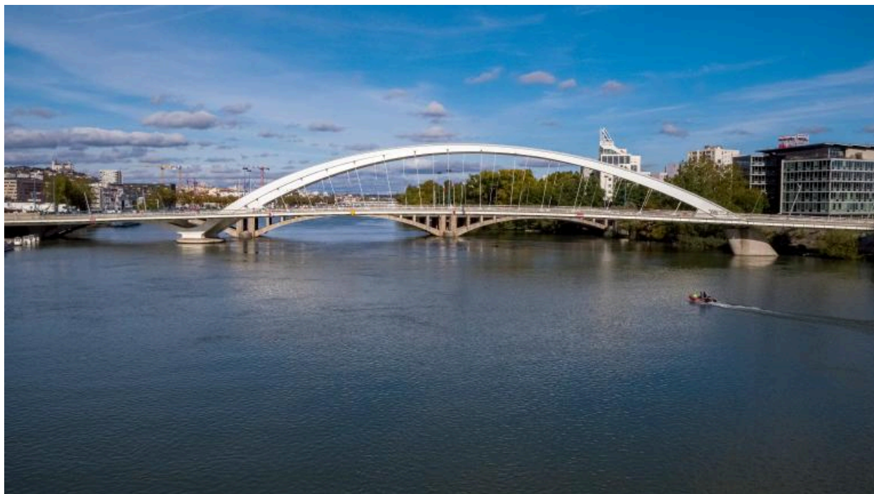
Vue sud du pont Raymond Barre (drône).
