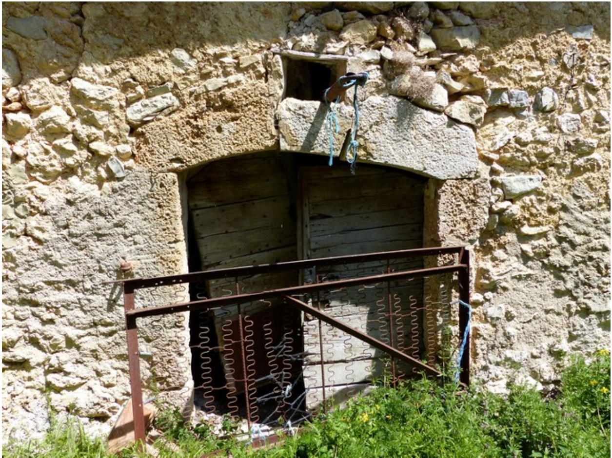
Ensemble oriental. Partie nord. Elévation ouest, porte de l'étable.
