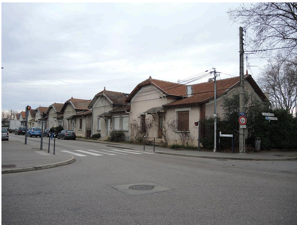
Cité ouvrière Maréchal vue d'ensemble des maisons
