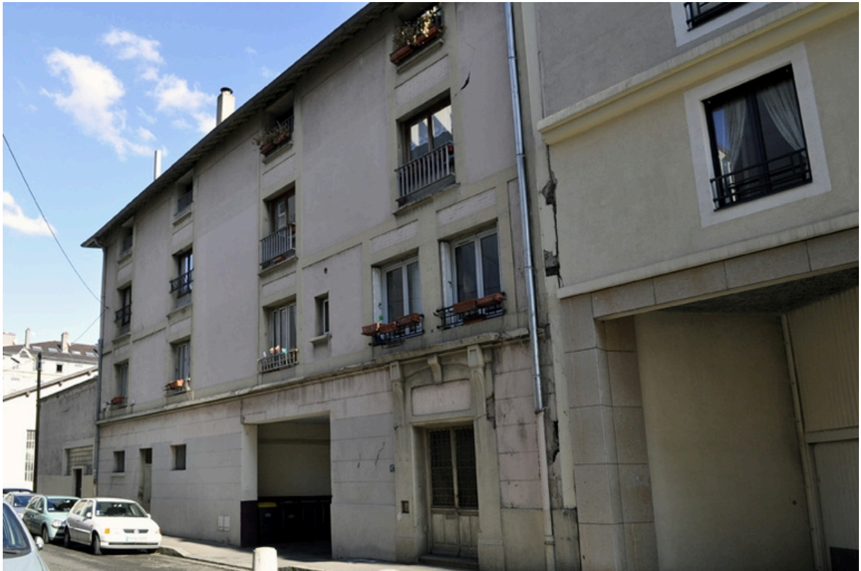
Façade rue d'anvers, vue nord
