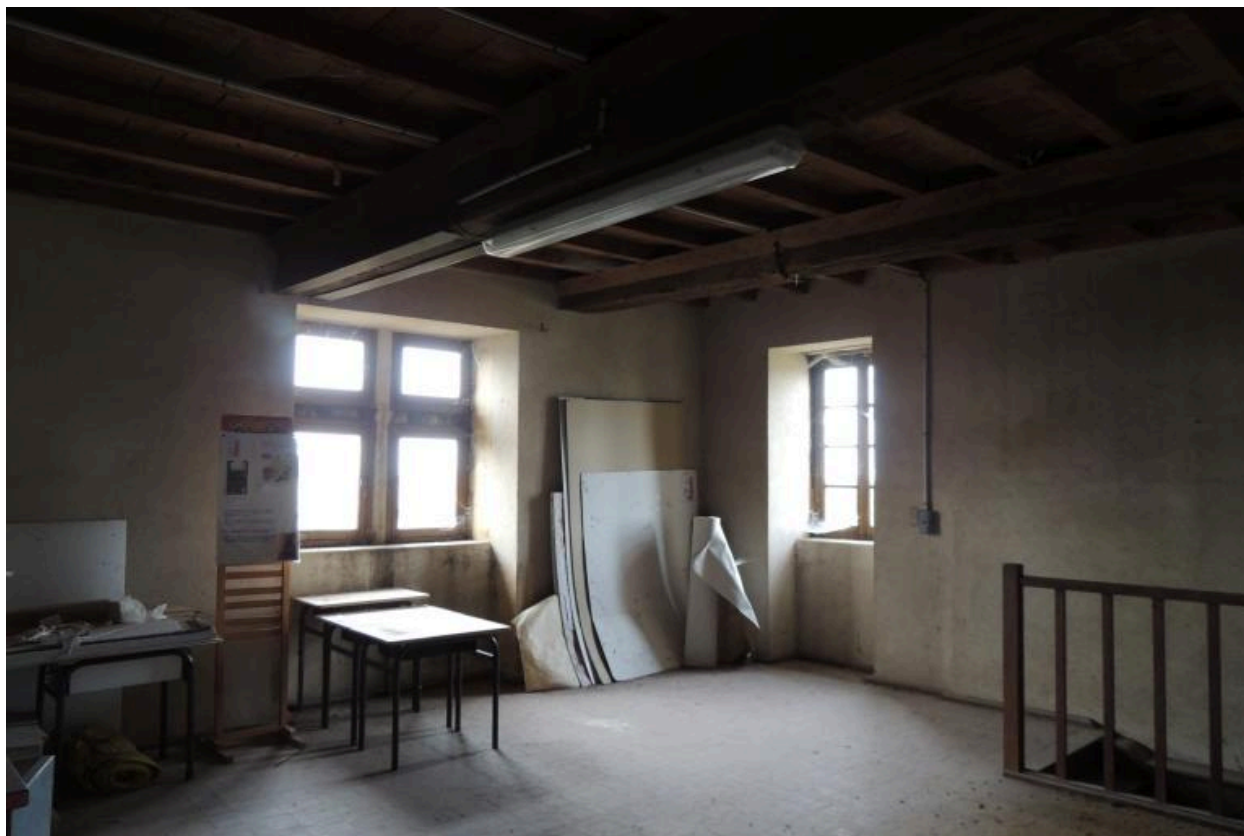
Tour sud-ouest : intérieur, étage.
