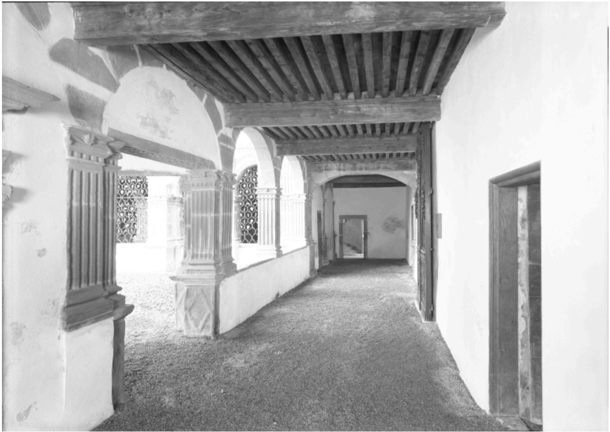
Corps de galerie, rez-de-chaussée : vue du portique au niveau du pavillon formant saillie, du nord.
