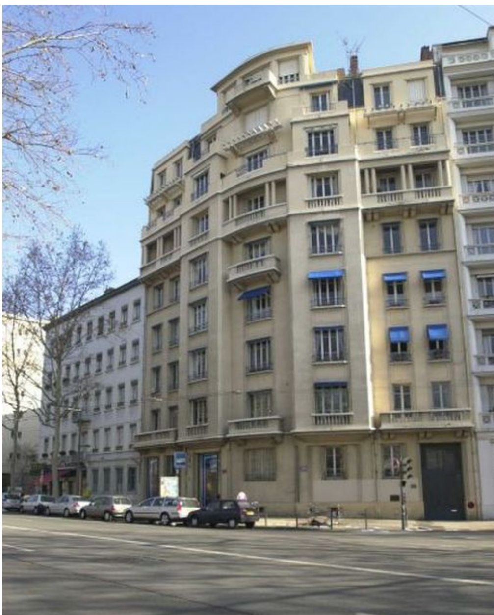
Vue générale depuis le sud-ouest
