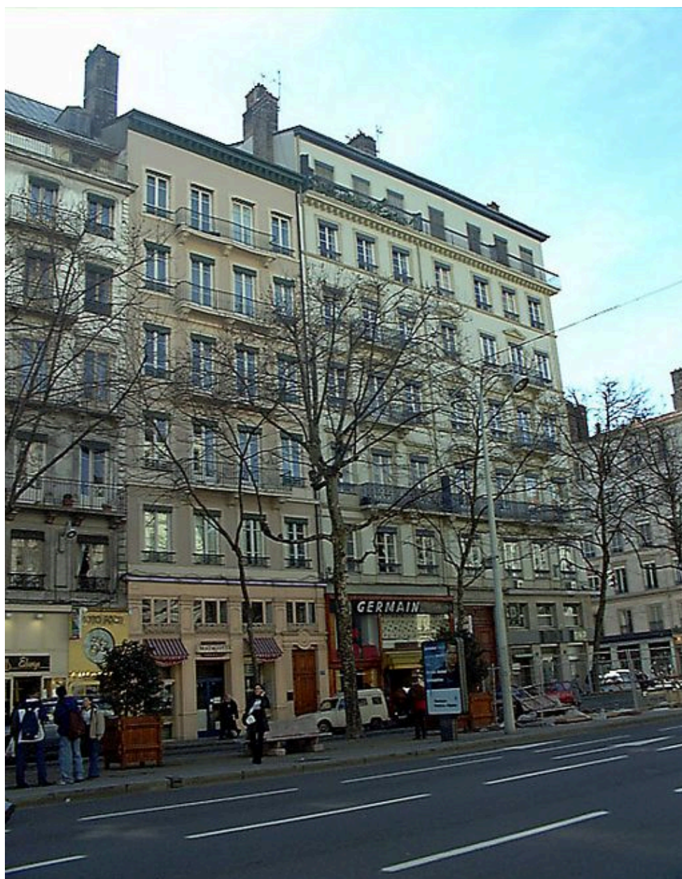
Façade sur rue, vue générale
