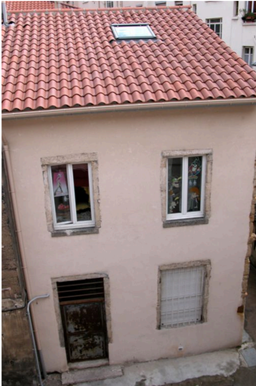
Elévation sud sur cour
