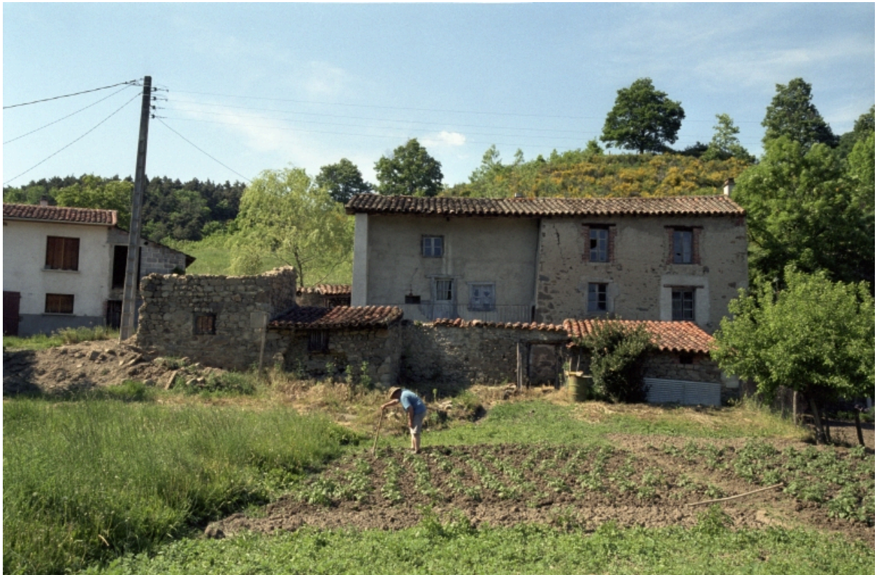
Pralong, Rangon (1987 A2 1166), type C1. Vue générale depuis le sud.
