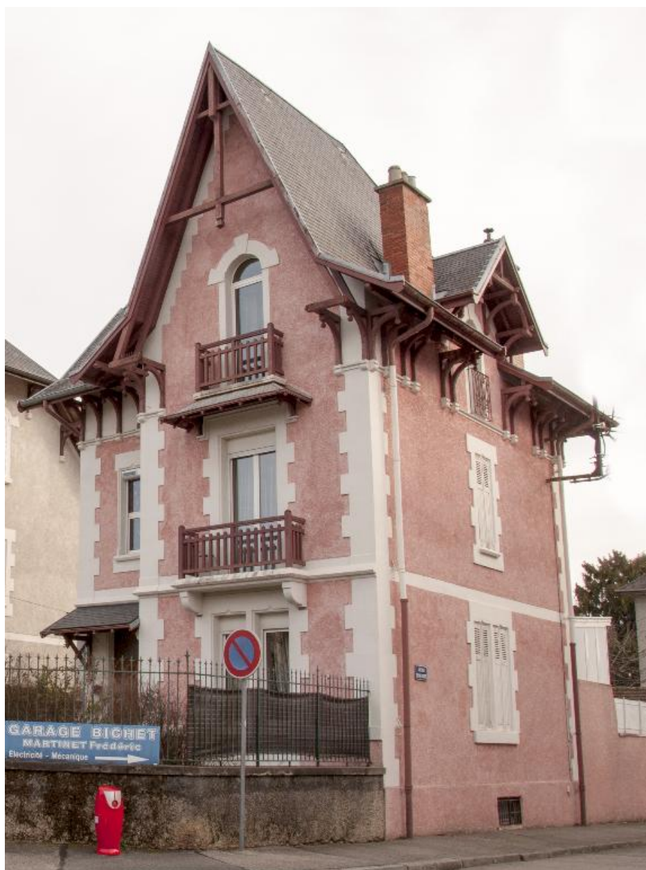
Façade principale (nord) et pignon est
