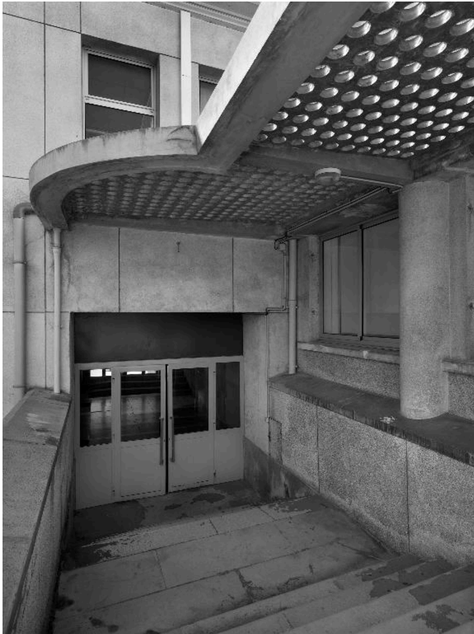
Petite cour, angle nord : détail de la marquise et porte ouvrant sur le bâtiment principal
