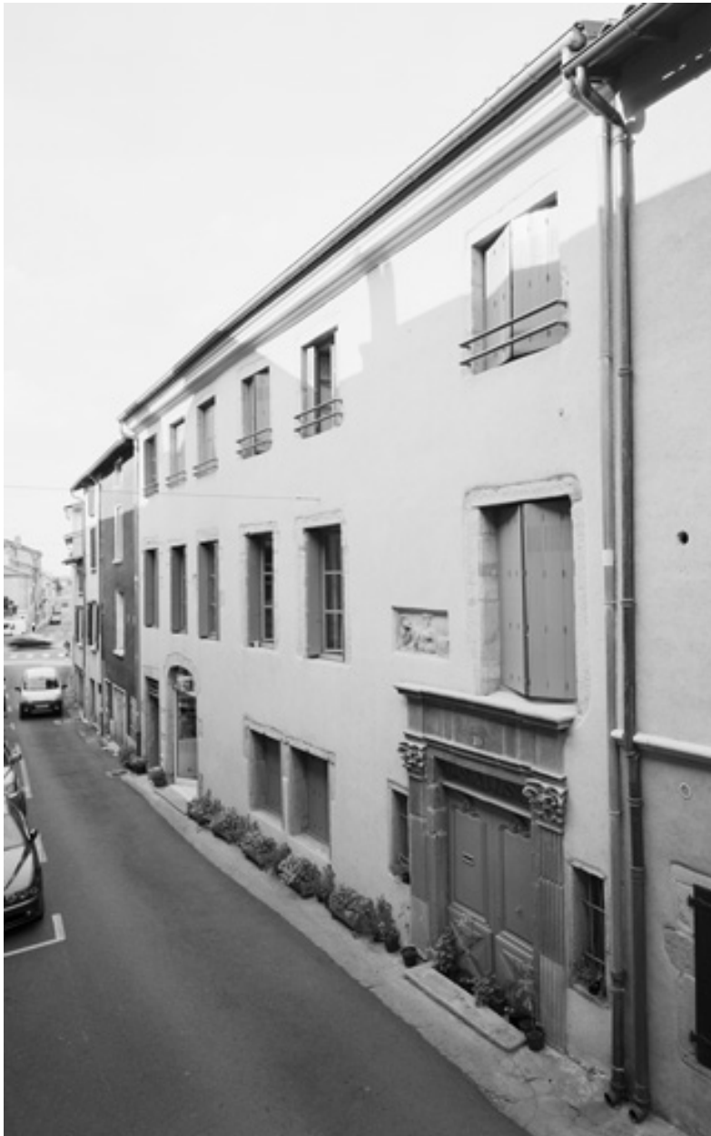
Vue générale de l'élévation sur rue.
