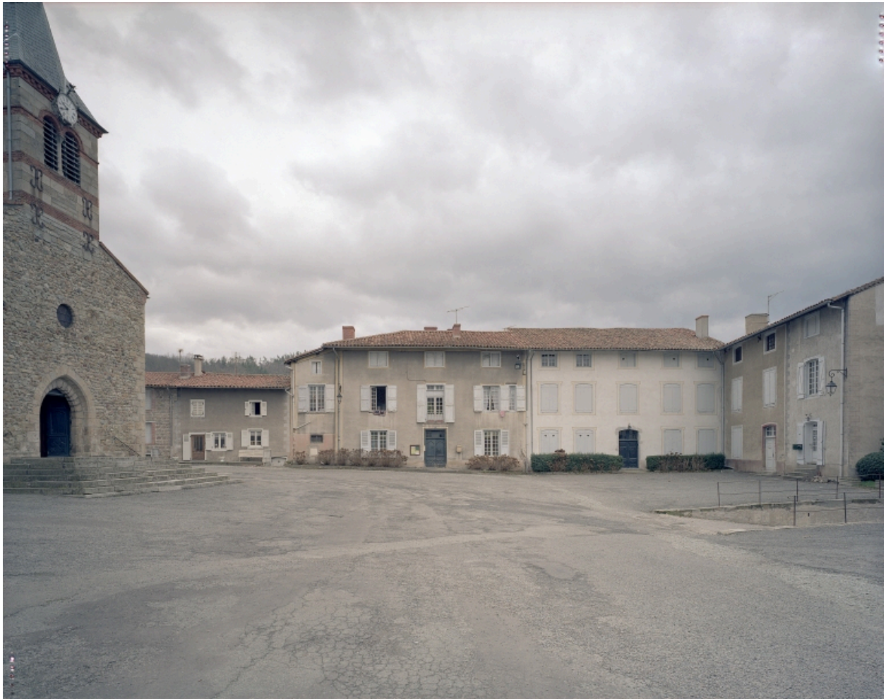
Vue de l'enclos canonial, depuis le nord.
