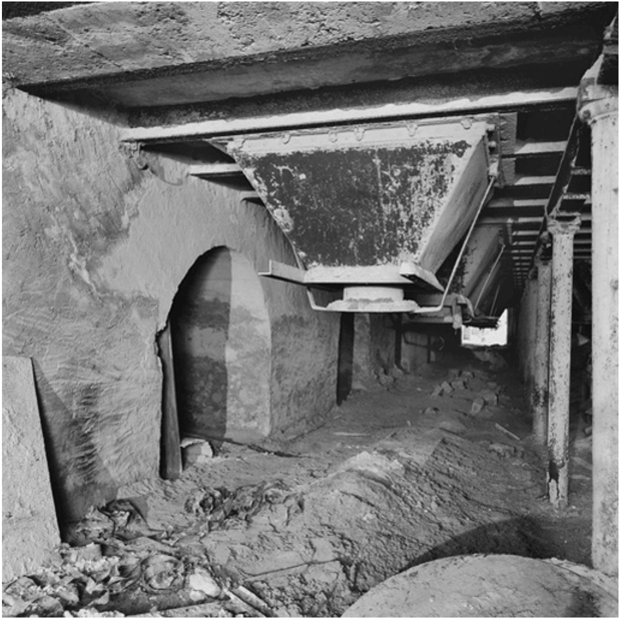
Vue intérieure des locaux
