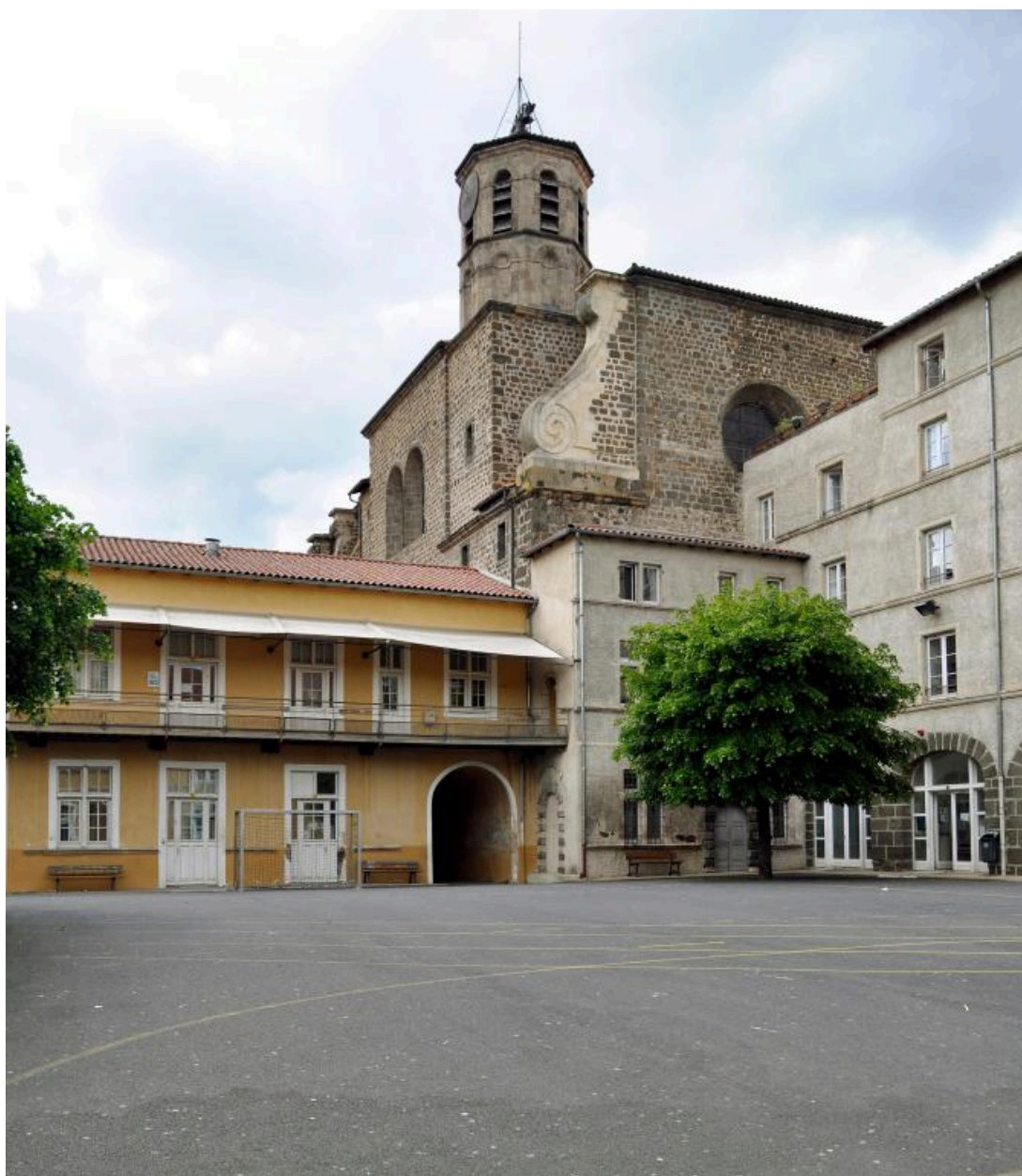
Cour 2, angle nord-ouest
