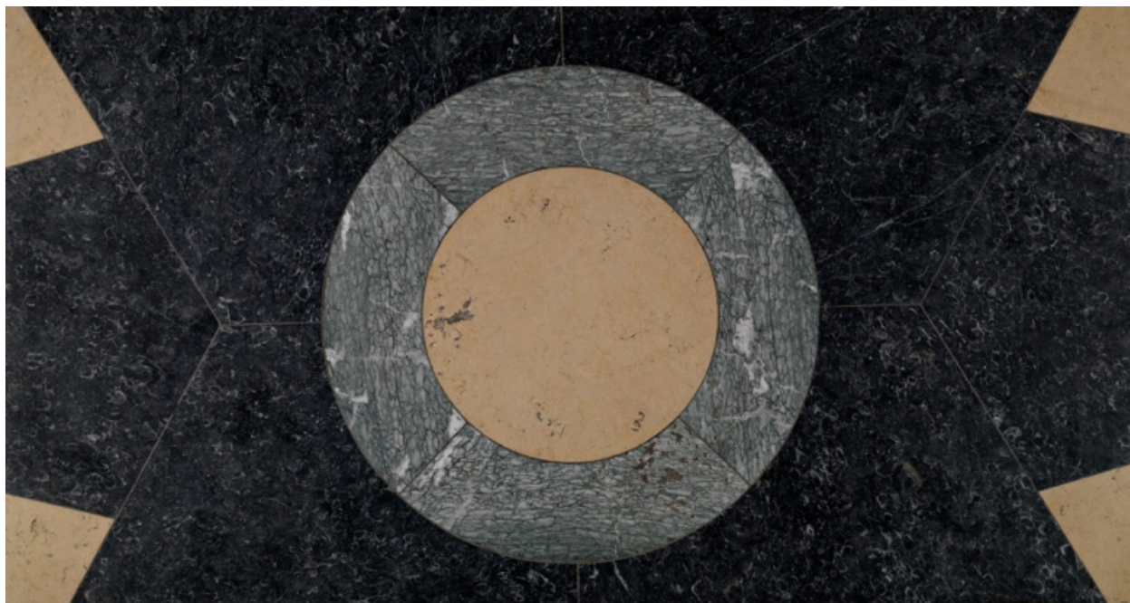
Le dôme Soufflot. Rez-de-chaussée. Détail du carrelage du vestibule
