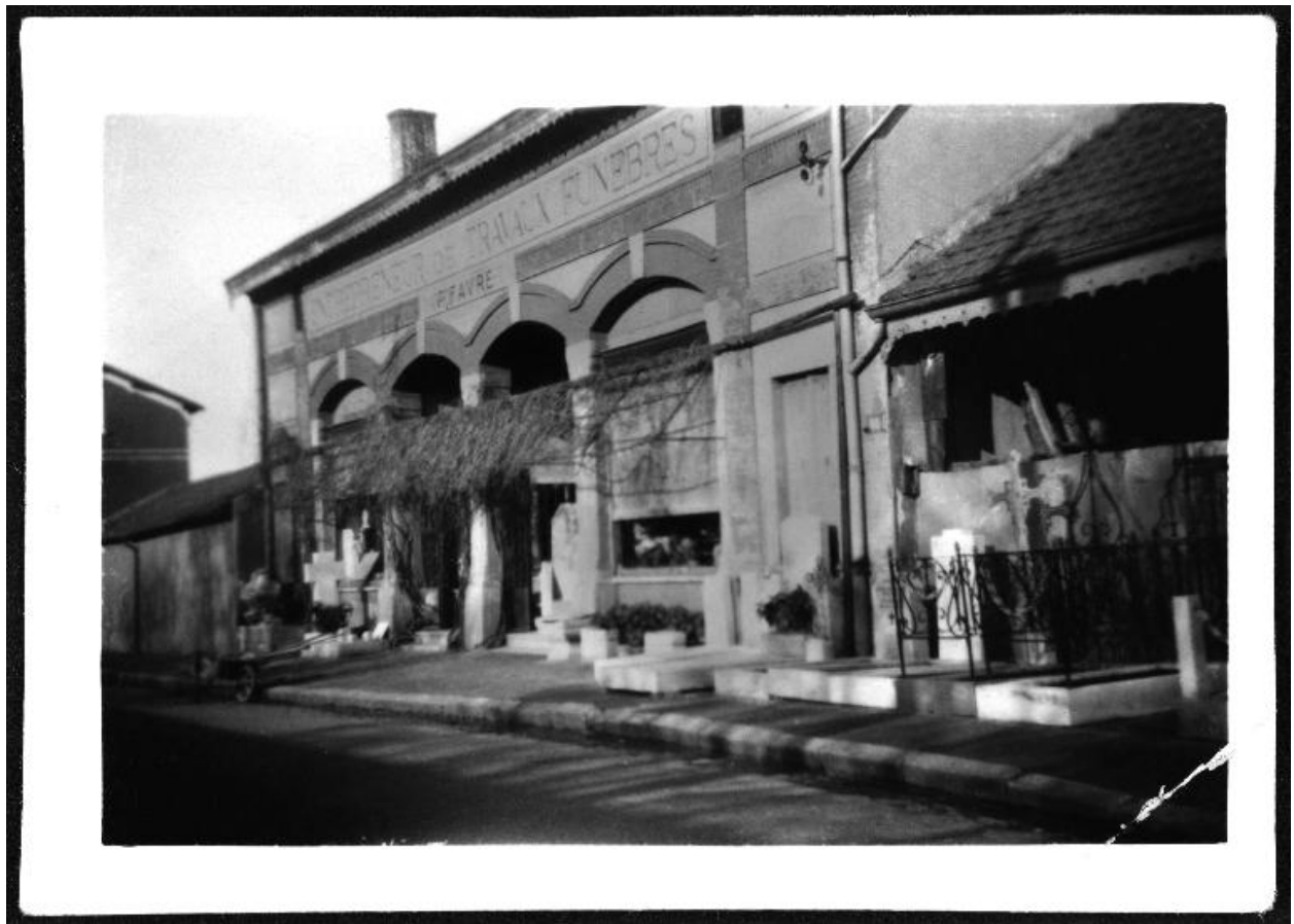
Vue partielle de l'élévation sur rue
