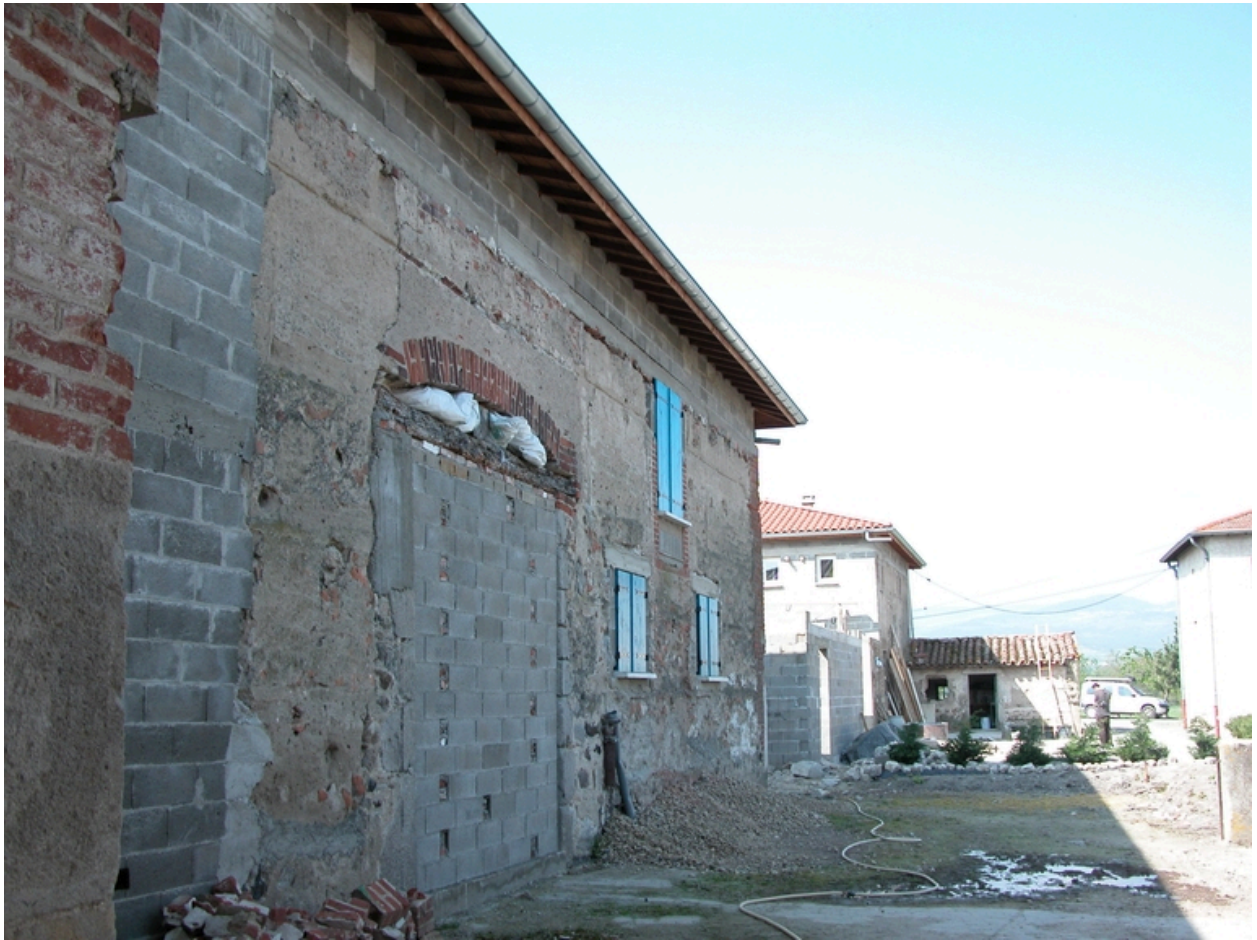
Vue du bâtiment sud, depuis l'est.
