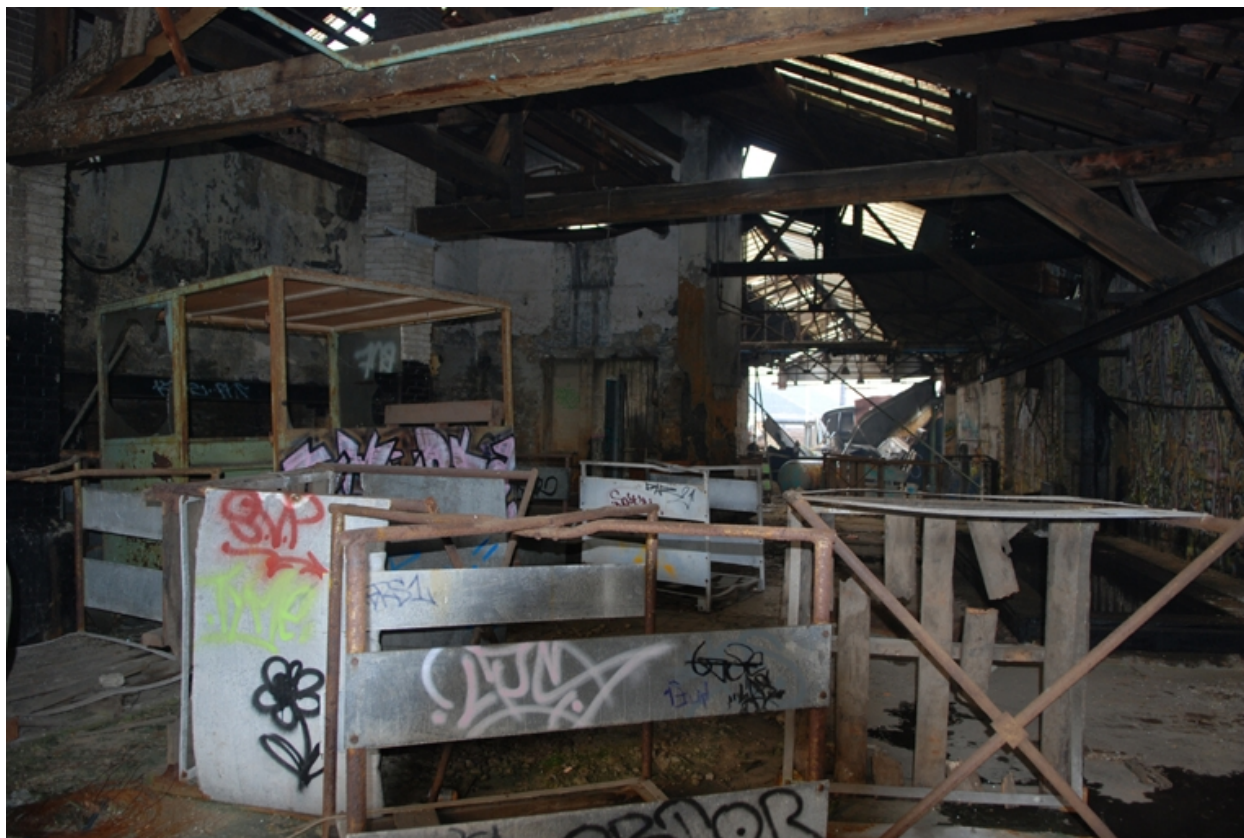
Vue nord-est des ateliers du rez-de-chaussée
