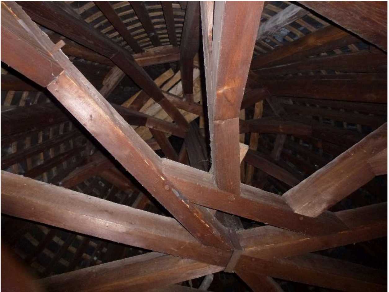
Détail de l'enrayure de la flèche conique. (Photo chercheur).
