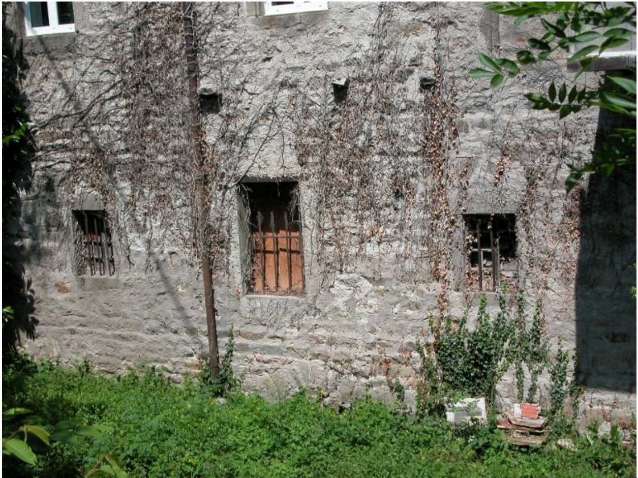
Détail du premier niveau du second corps de bâtiment, façade sud-est du moulin.
