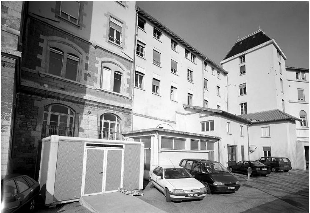
Grande façade est, partie nord
