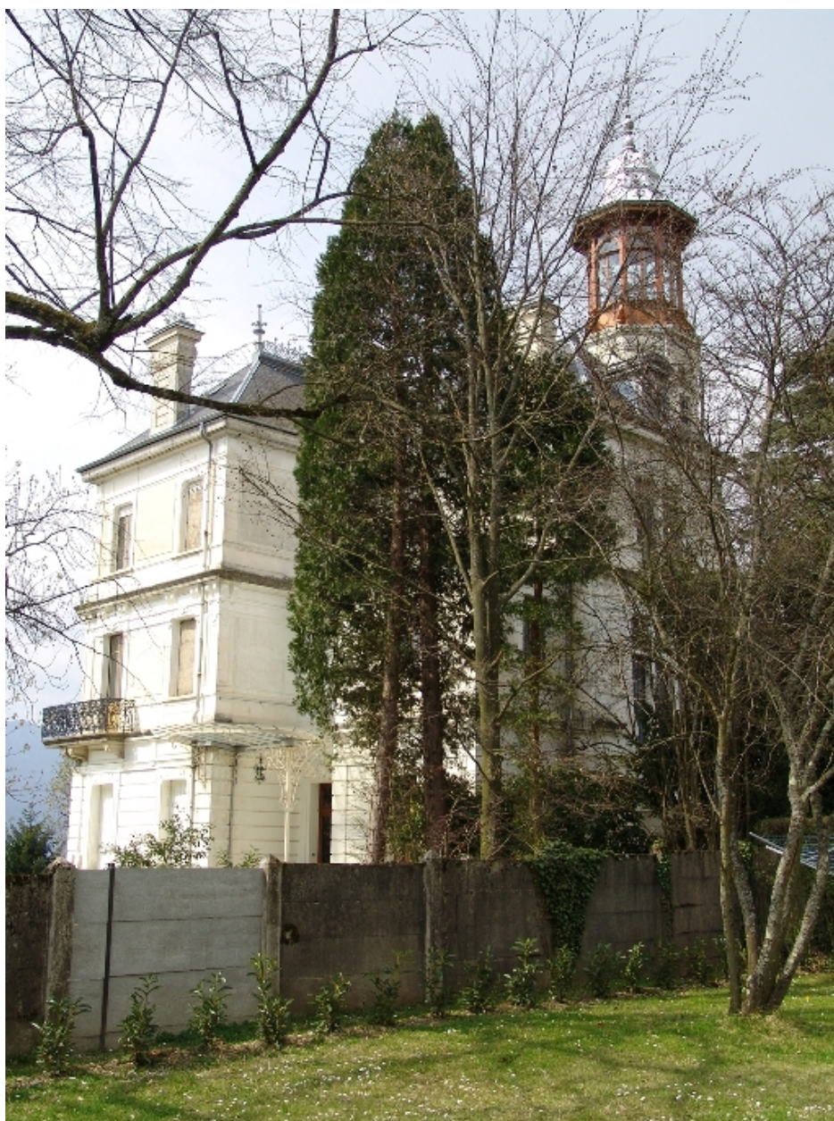
Façades postérieure et latérale droite
