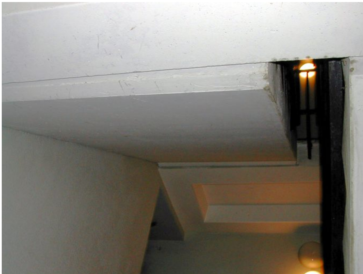
Détail des circulations intérieures
