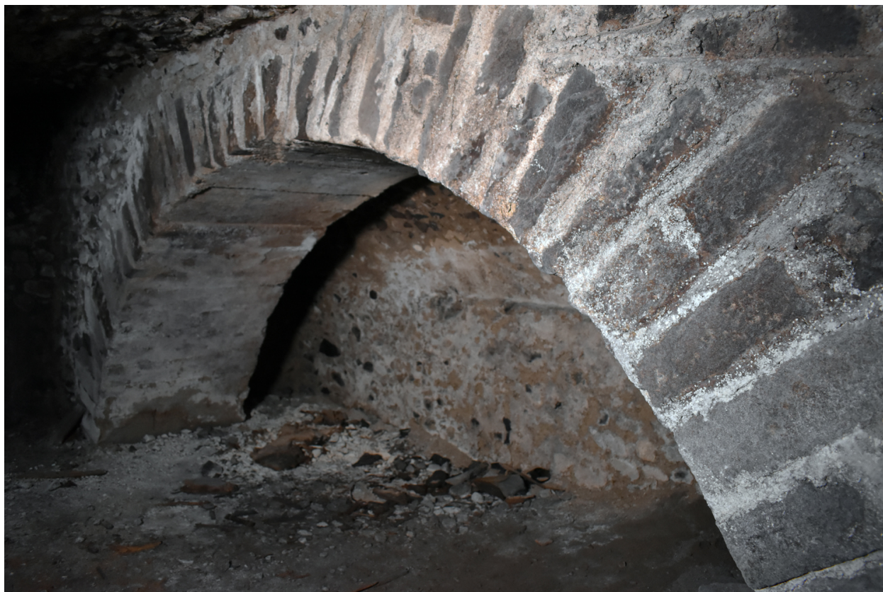
Caves nord, salle n°12 : arcade
