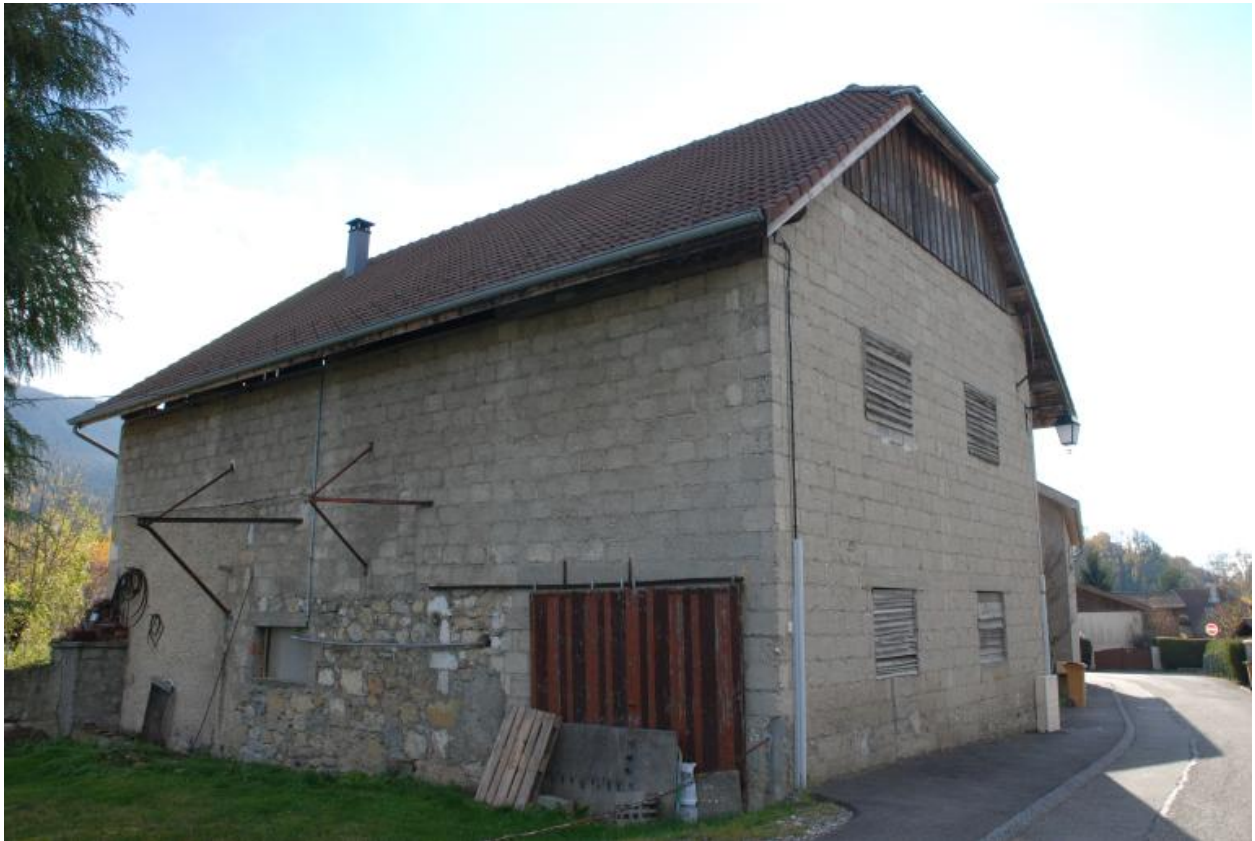
Elévation postérieure du bâtiment principal : maçonnerie de parpaing de béton artisanal.
