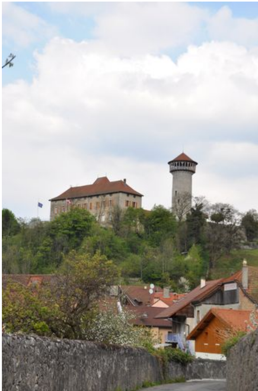
Vue d'ensemble du chateau de Faverges
