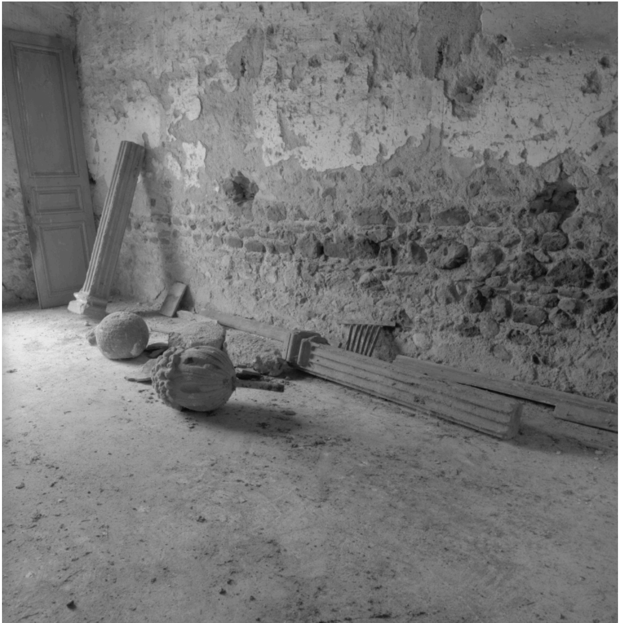
Détail d'éléments de décors architecturaux provenant de la façade.
