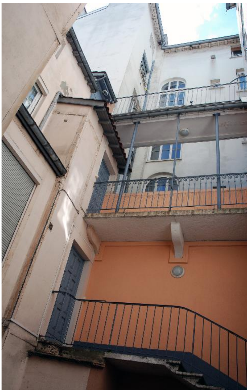
Vue des coursières d'accès depuis le 2, quai Claude-Bernard
