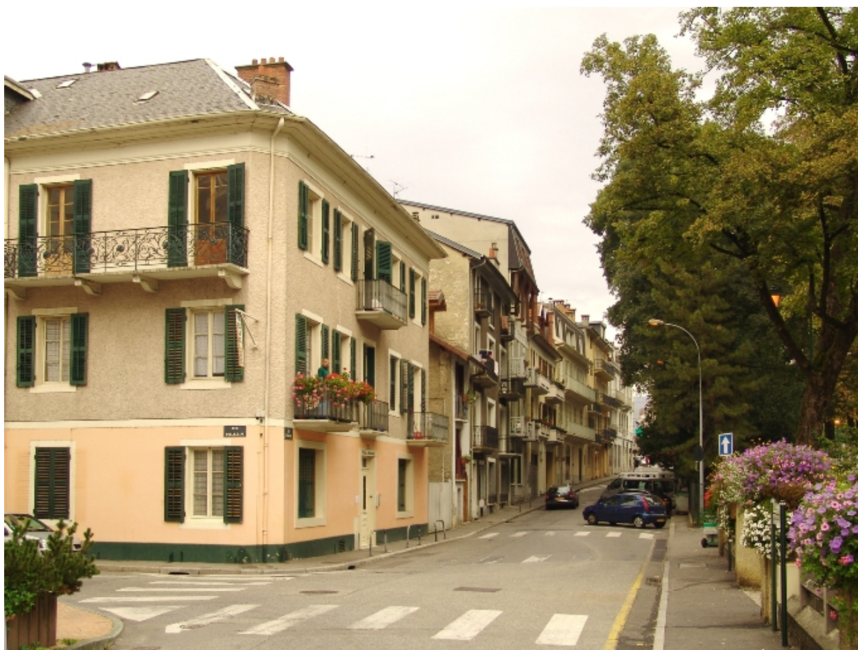
Vue depuis le sud
