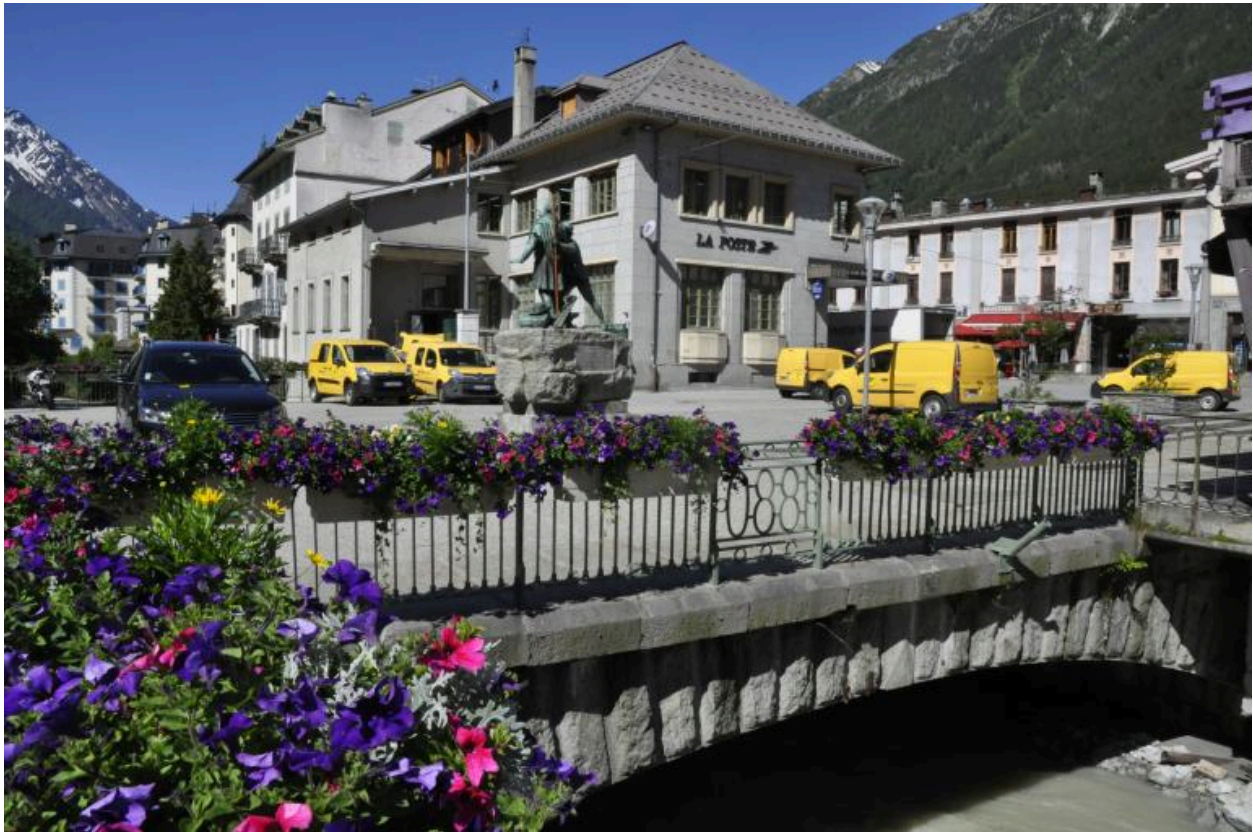
Vue de la face amont de l'ouvrage
