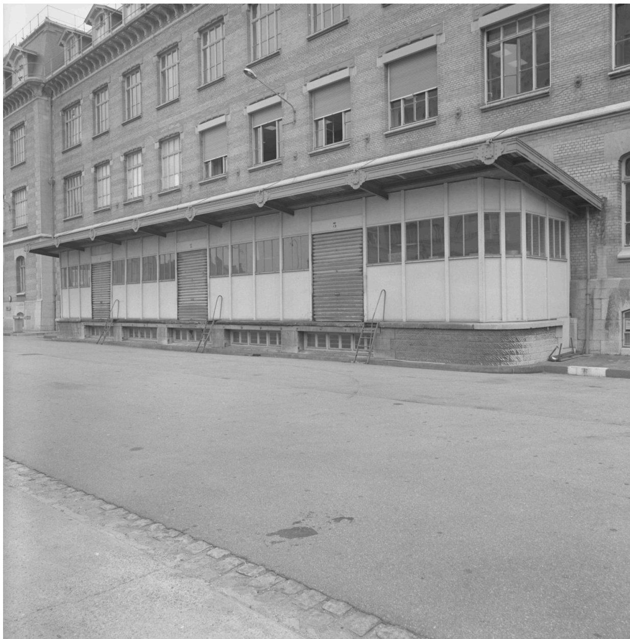
Quai de chargement, façade sud du bâtiment
