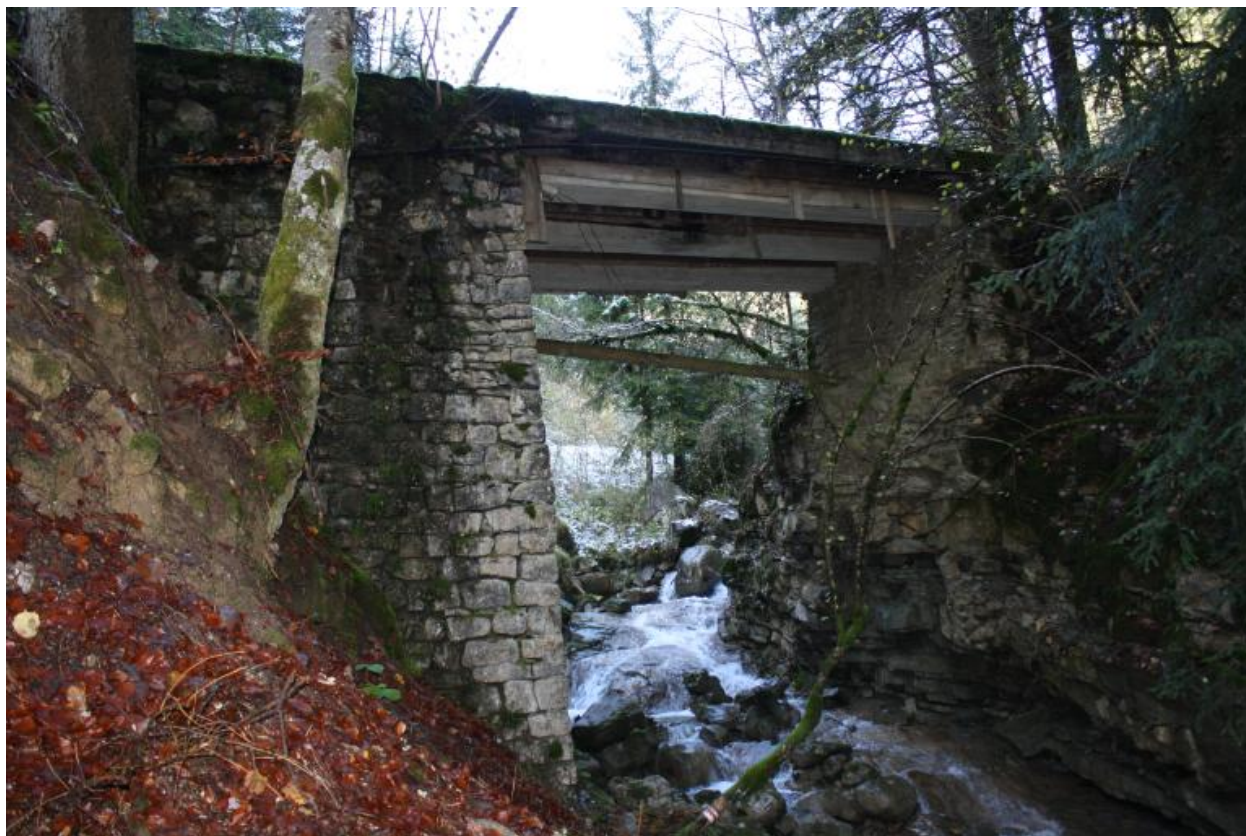
Vieux pont des Landoz, face aval
