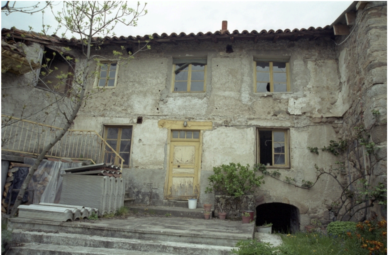
Pralong, la Fouillouse (1987 B1 152), type B1. Façade antérieure du logis.
