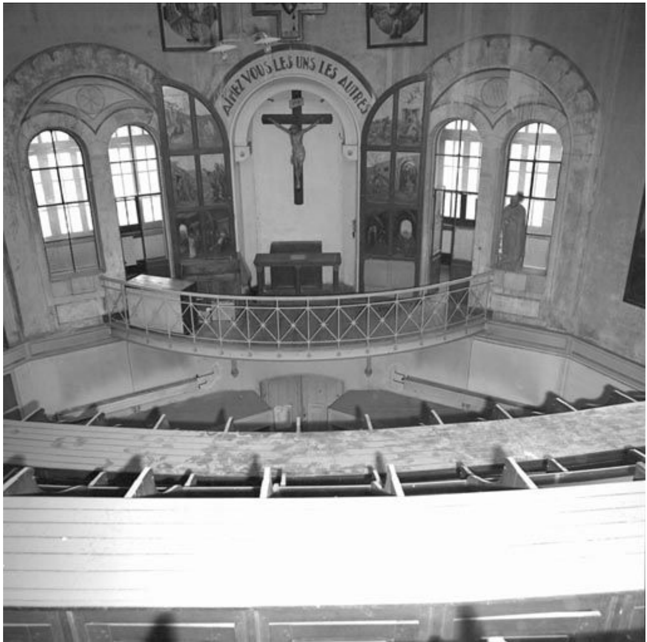
Chapelle : vue rapprochée du choeur, état en 1984
