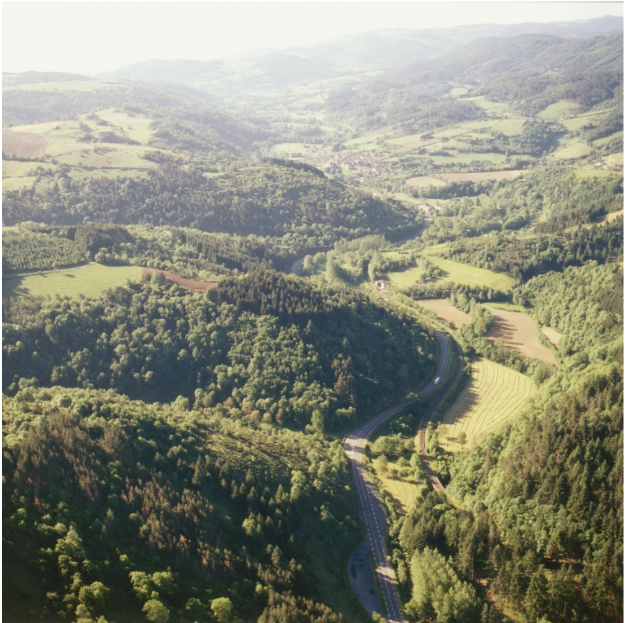
Vue aérienne de la RN 89, en direction de Clermont-Ferrand.
