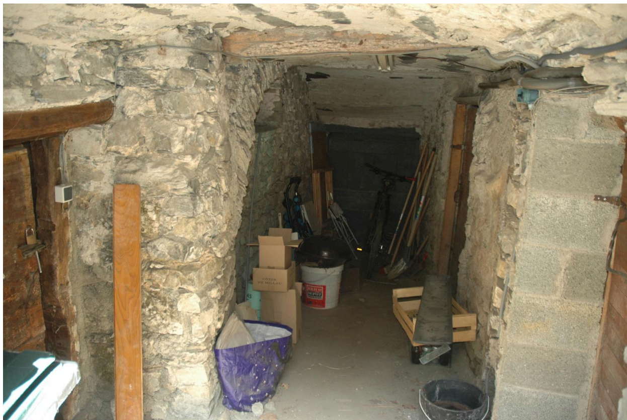
Maisons de vigneron (2018 A5 1042), couloir partagé d'accès aux caves.
