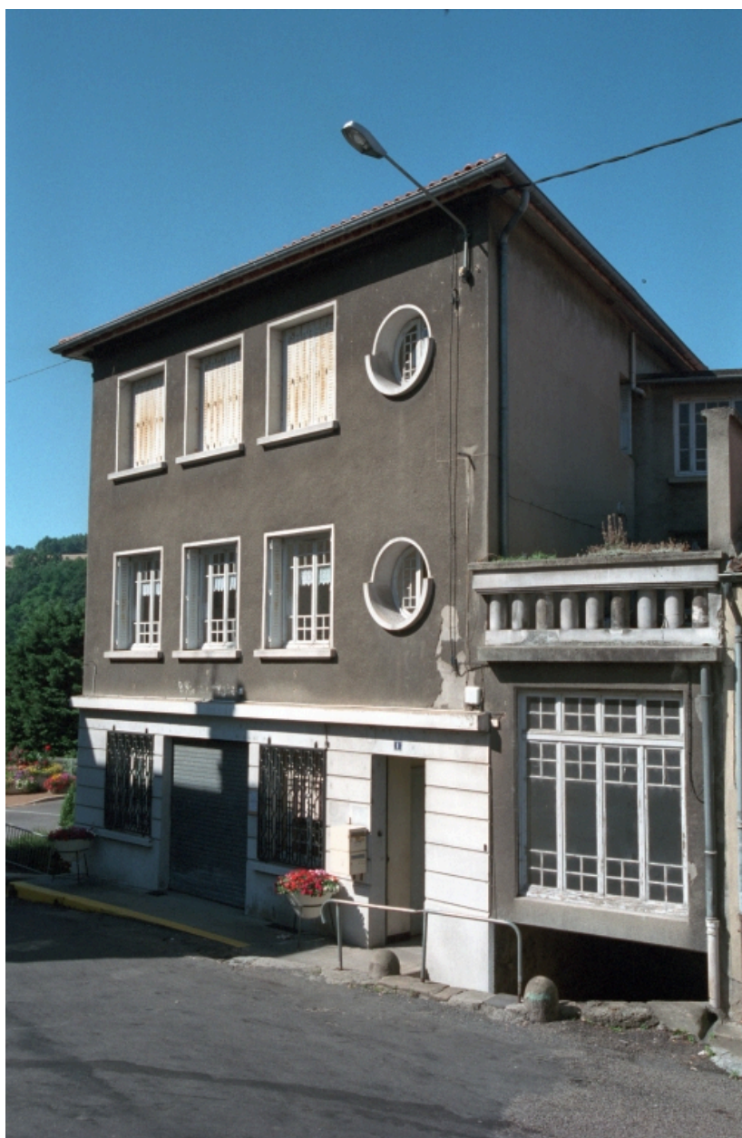
Boën, îlot 13, Gustave Labrosse (rue) 1. Vue générale de la façade sur rue.
