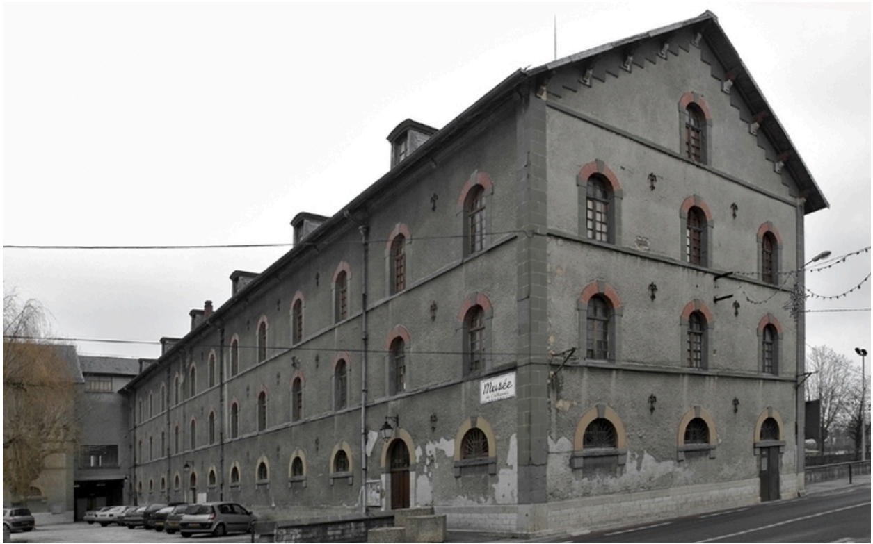
Aile sud qui va être démolie (emplacement actuel du musée)
