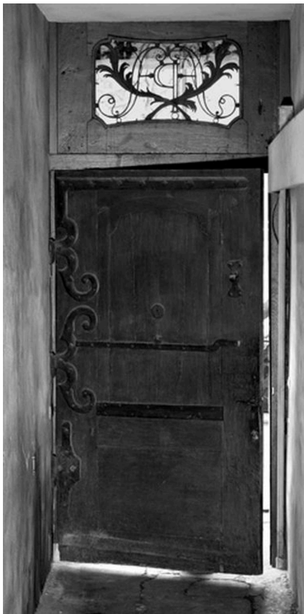
Allée 27 quai Saint-Antoine : revers de la porte d'entrée
