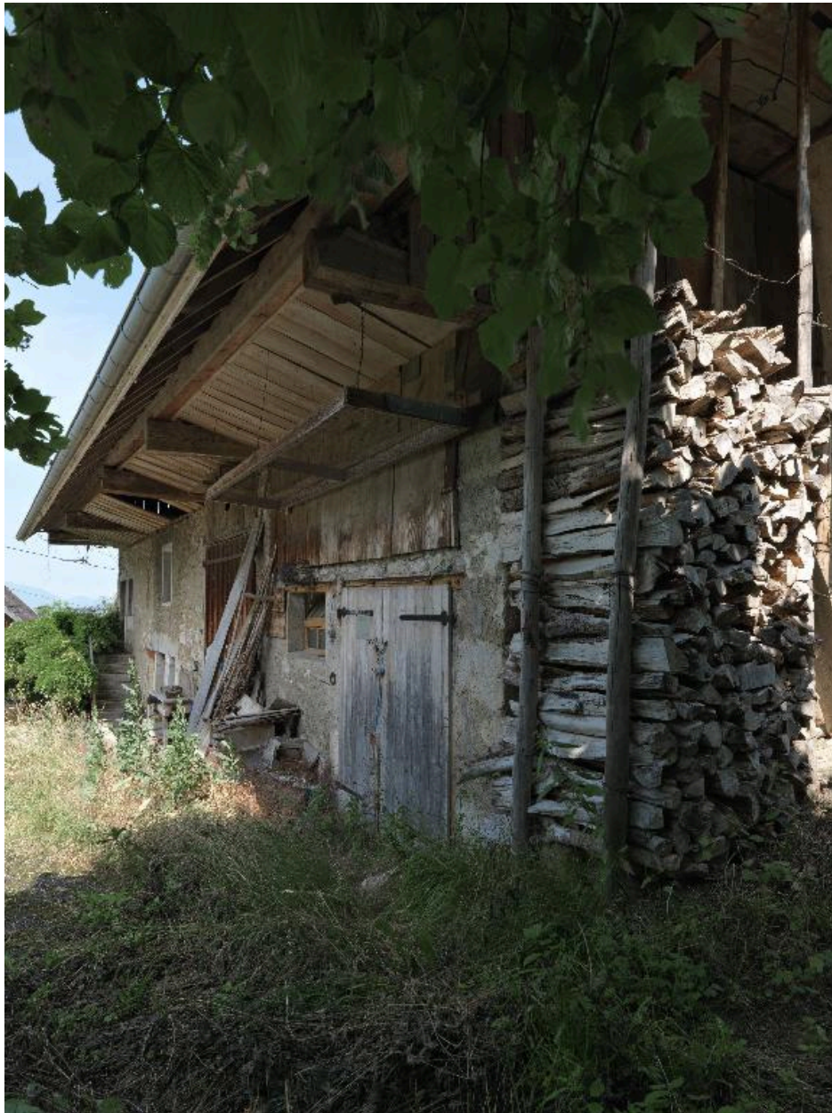
Vue d'ensemble depuis le sud-est : grange-étable, bûcher.
