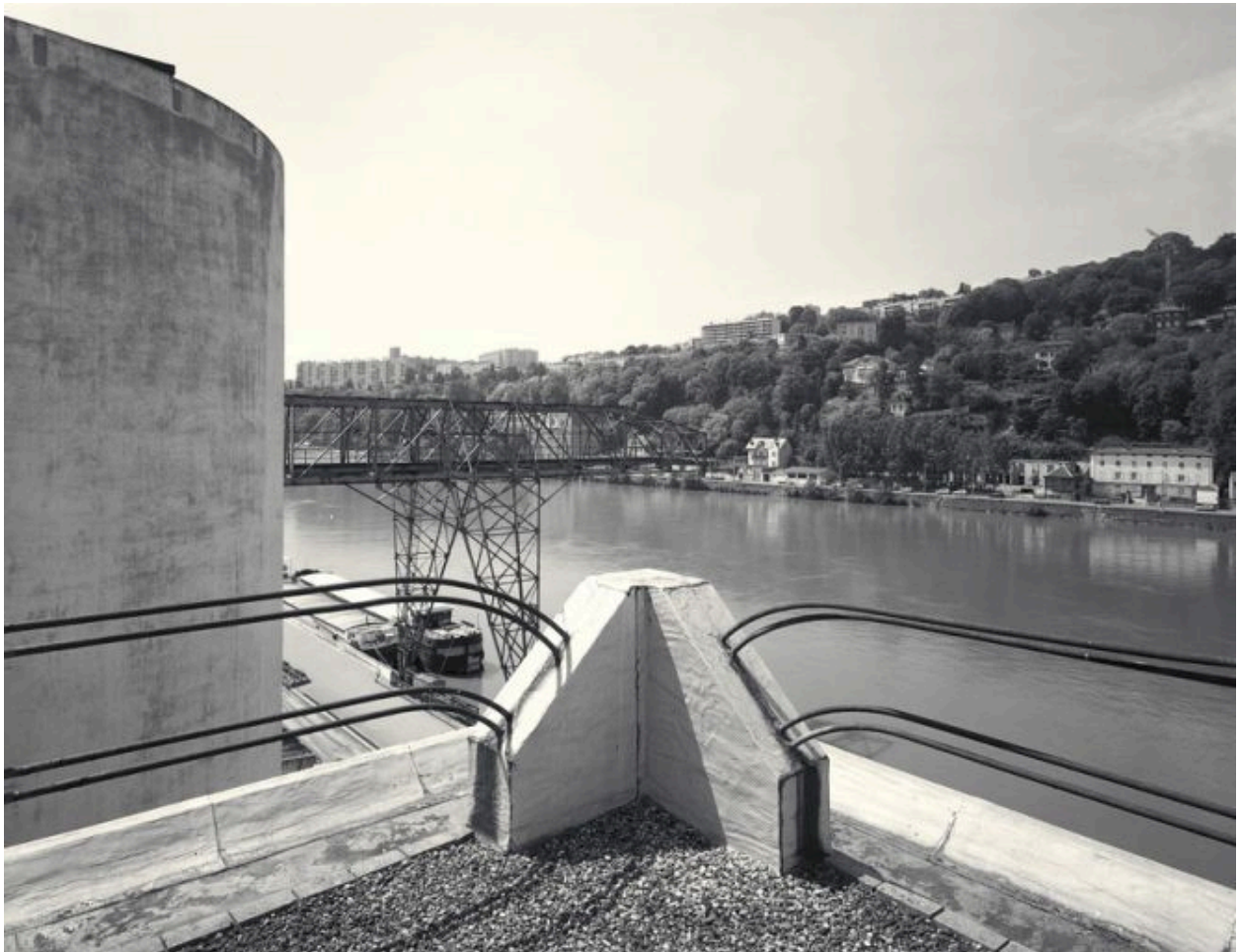
Angle sud-ouest du toit terrasse
