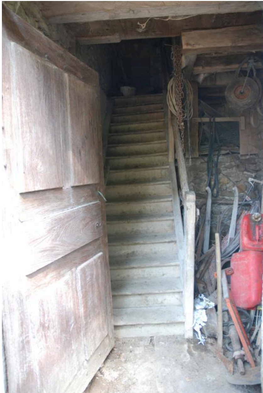
Vue intérieure du fournil-grenier : entrée et escalier.
