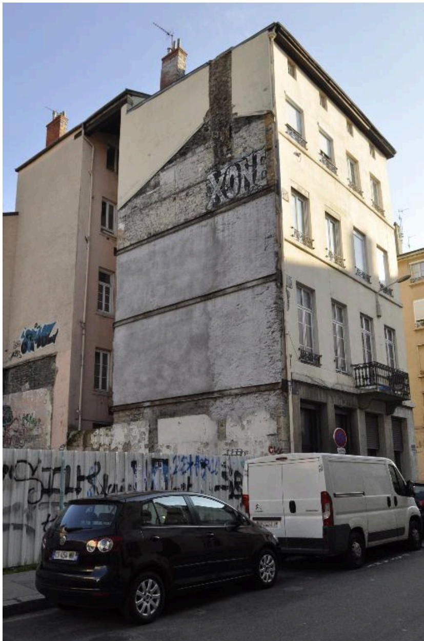
Pignon ouest, révélé pendant la démolition des immeubles mitoyens
