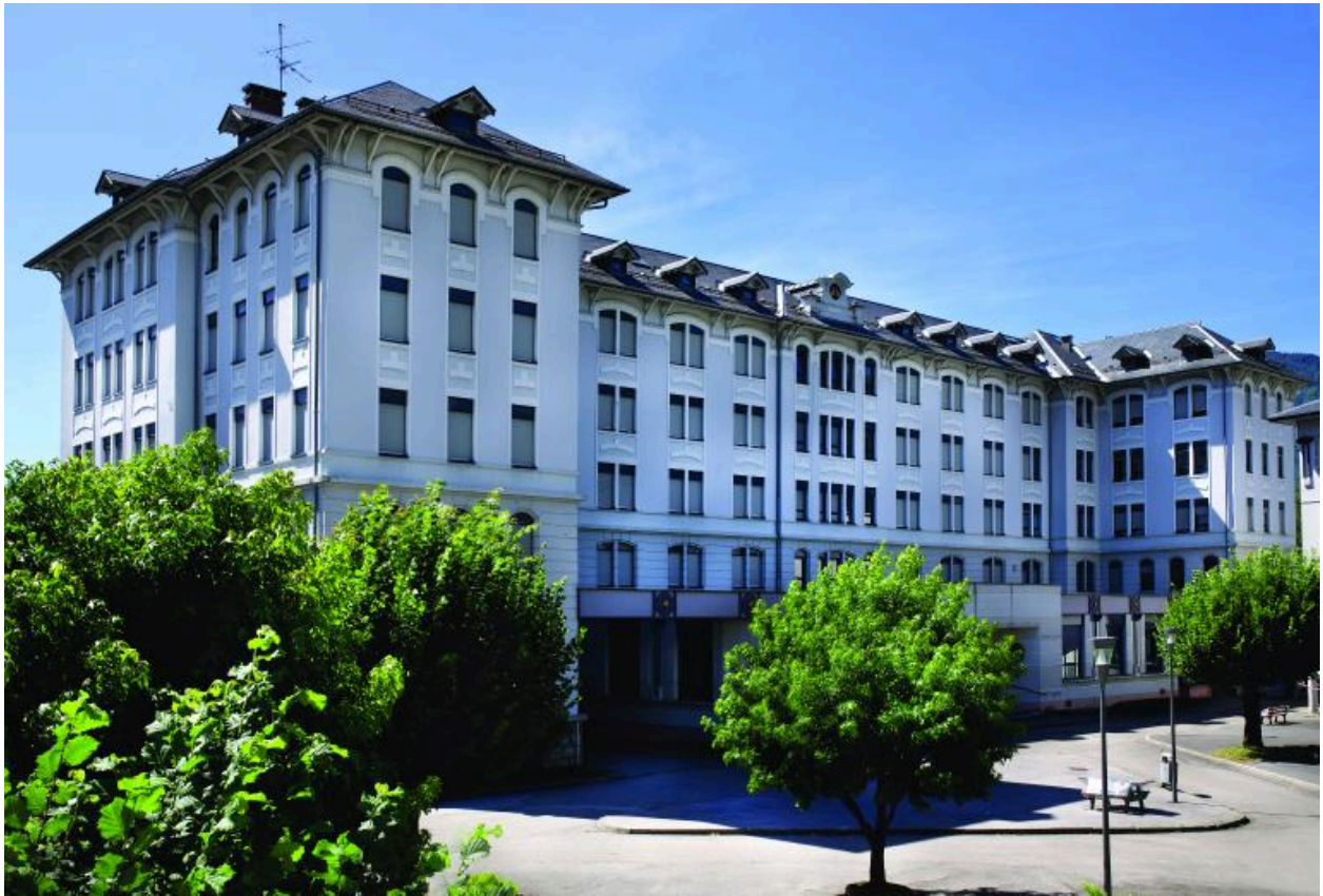
Internat, vue d'ensemble
