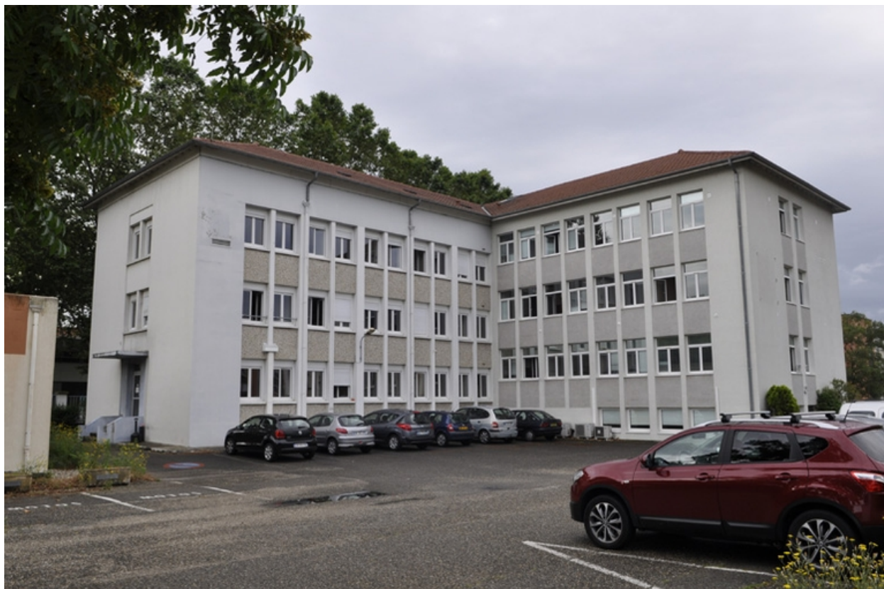
Bâtiment administratif datant des années 50.
