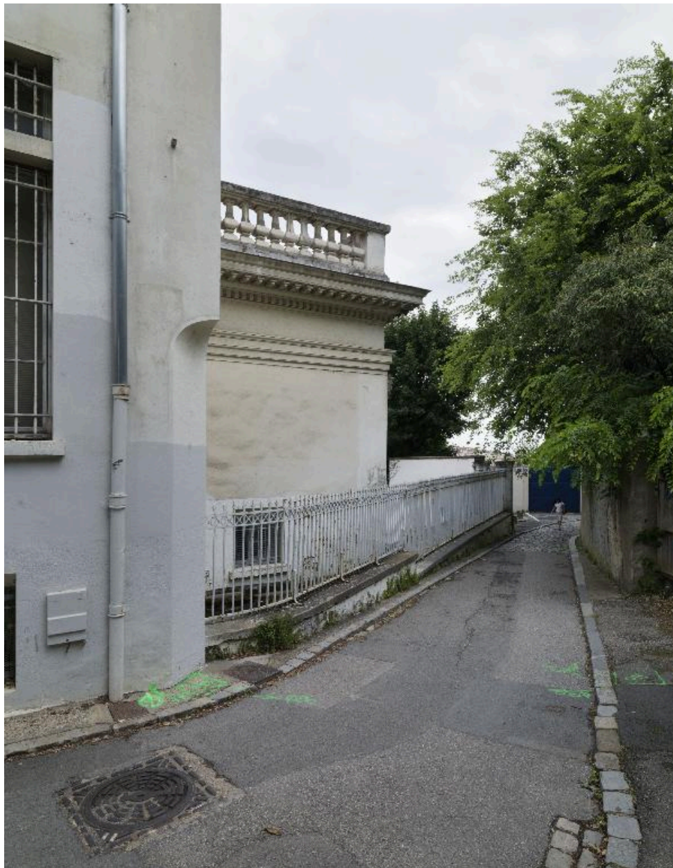
Vue latérale du porche, depuis le chemin de Montauban
